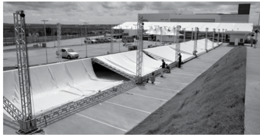
No estacionamento do Metropolitana foi montada moderna estrutura hospitalar
